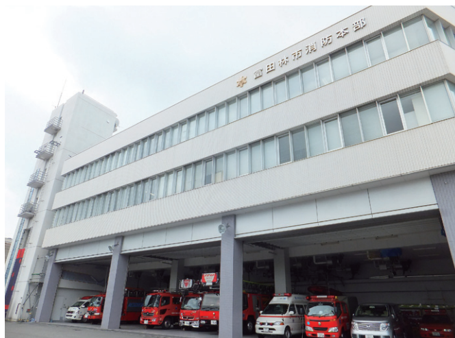
富田林市消防本部庁舎
